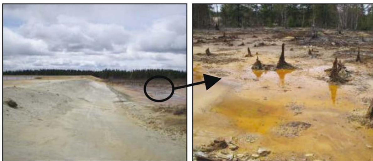
Figure 1 : Photographies d'un parc à résidu abandonné affecté par la production de drainage minier acide et de ses environs (Abitibi-Temiscamingue, Québec)
